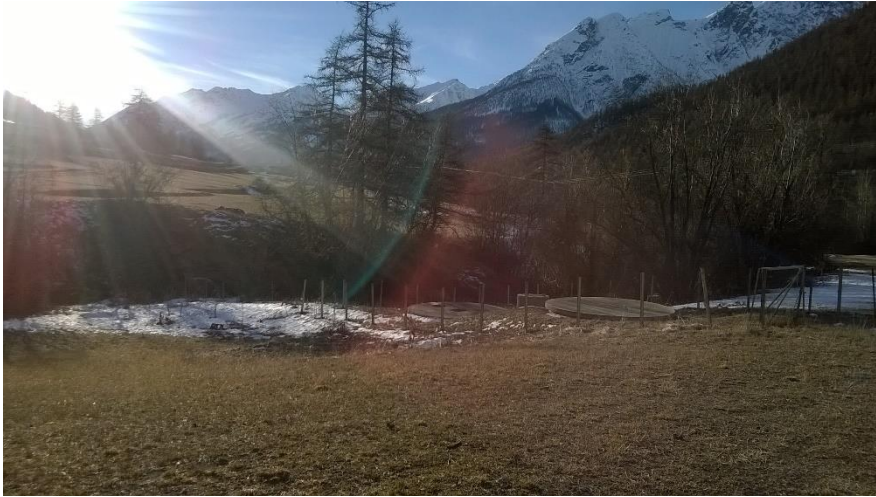
Station d'épuration des Boussardes, Monêtier-les-Bains
