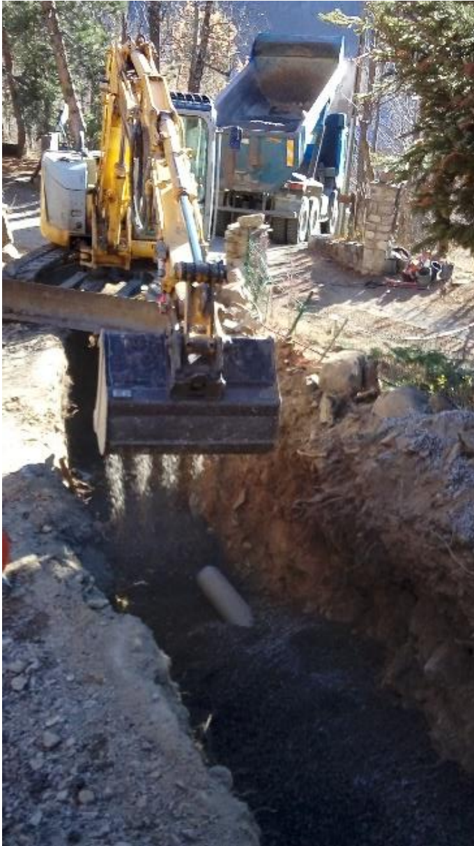
Chantier du chemin de la Teinture, La Salle les Alpes
