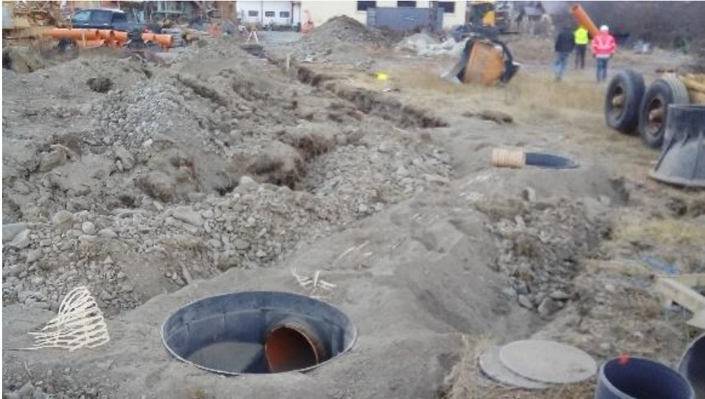
Chantier de la Zone des Sables 2, Monétier-les-Bains
