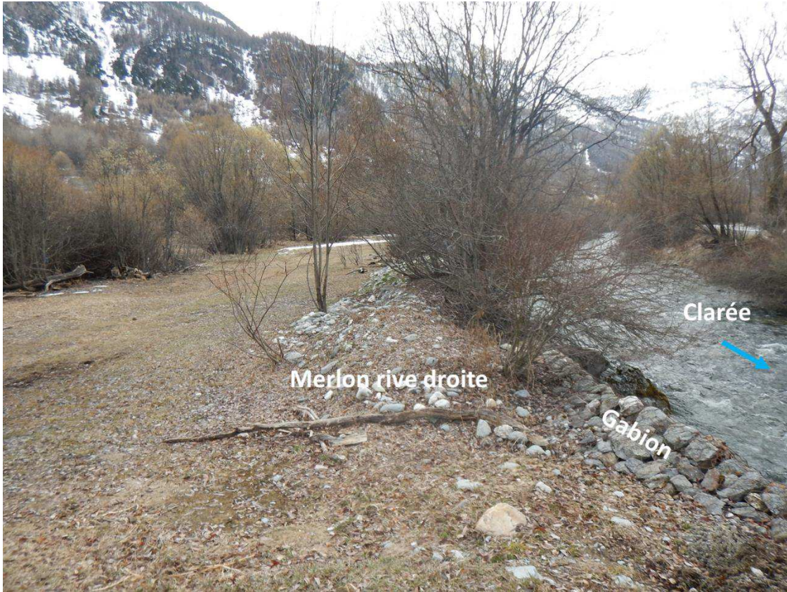
Figure 19 : Vue vers l'amont de la berge rive droite depuis le pont de Ville Basse (avril 2017)
