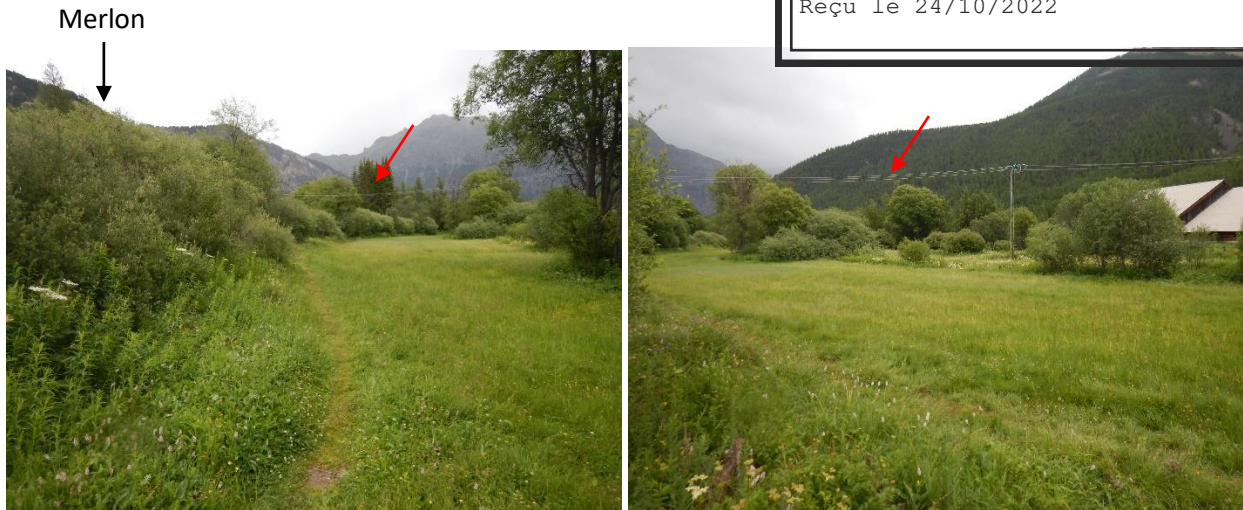
Figure 30 : Ligne aérienne HTA vue depuis l'aval rive droite du pont de Ville Basse, vers l'aval
