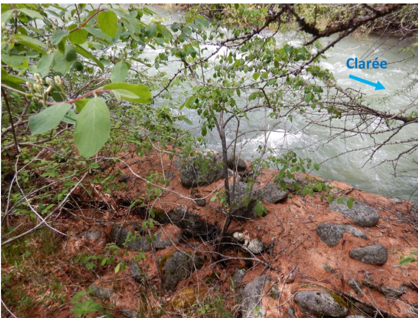
Figure 18 : Zone de la Gravière - gabion rive droite
