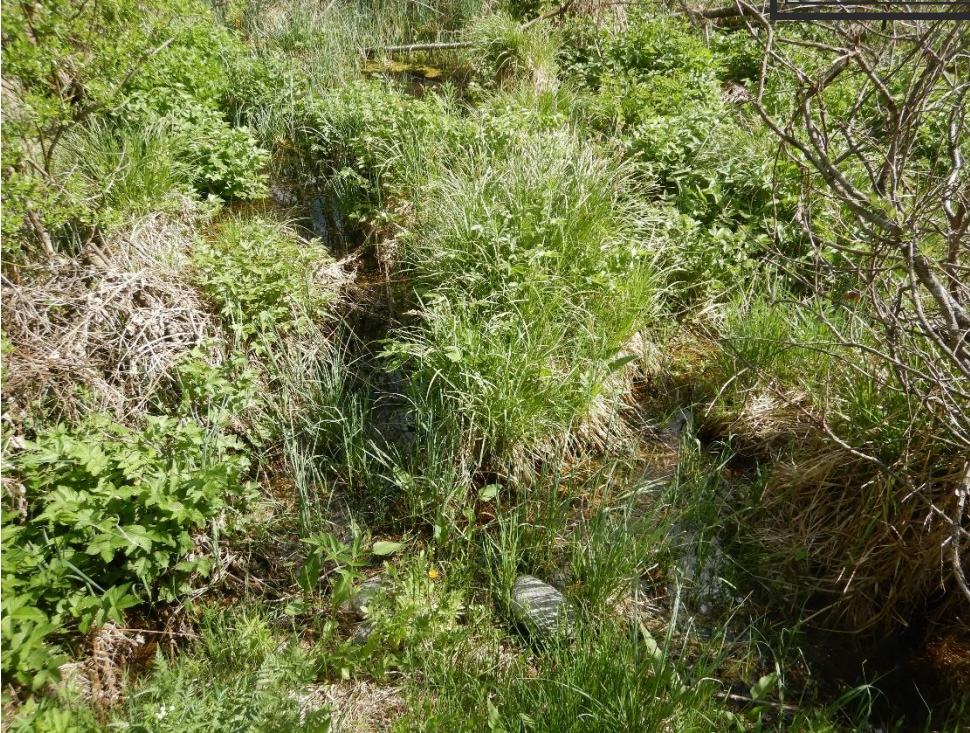
Figure 31 - Terrains gorgés d'eau en contrebas du merlon (amont P27, en rive droite, mai 2022)
