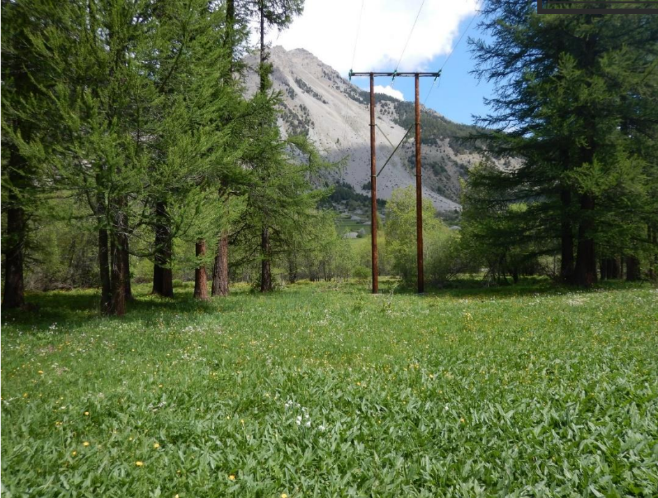
Figure 27 : Ligne aérienne HTA , support en rive gauche de la Clarée, vers le profil 24 (juin 2017)
