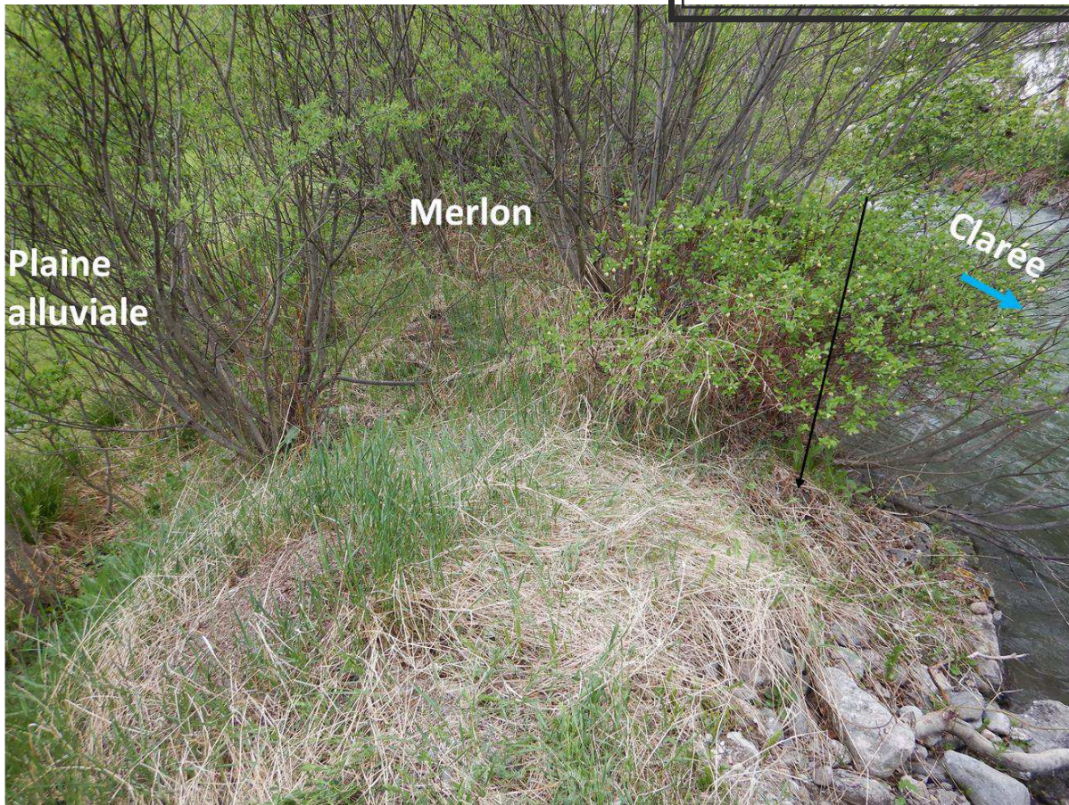
Figure 25 : Merlon au niveau de P31, vu de l'aval
