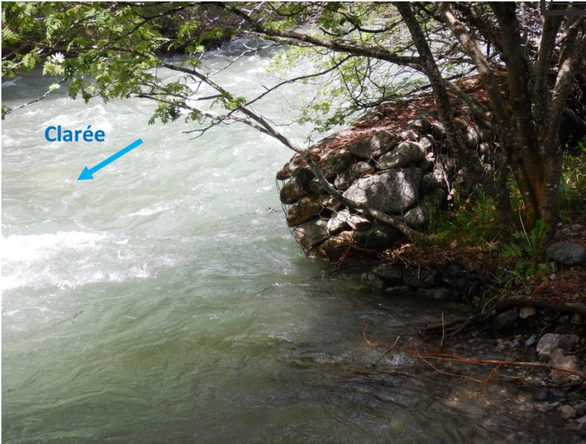
Figure 17 : Zone de la Gravière - extrémité aval du gabion rive gauche
