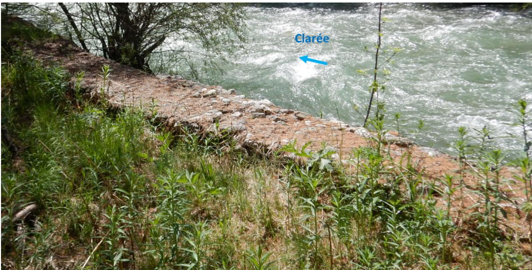
Figure 16 : Zone de la Gravière - gabion rive gauche
