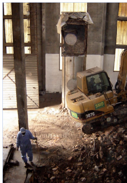
Dépollution de l'ancienne usine de Malefosse qui incinérail les déchets du Briançonnais
