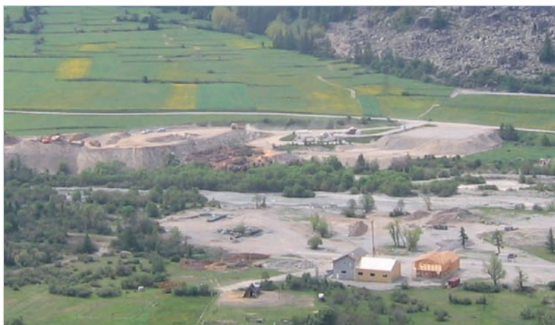
Actuelle aire de stockage des déchets du BTP - Le Monétier les Bains
