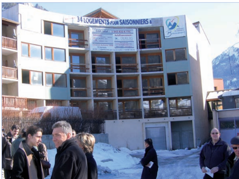
Lancement des travaux, le 8 février 2008
