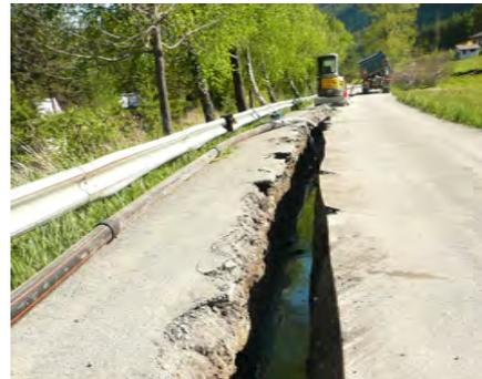
Les travaux de raccordement ont débuté en octobre 2011 (traversée camping des Rosiers, RD 201 jusqu'à l'entrée de la plaine des Alberts) Fin 2013 : un arrêté préfectoral portant sur la servitude de passage dans la plaine des Alberts a stoppé momentanément les travaux. La reprise et fin des travaux a eu lieu en novembre 2014 dans la plaine avec la mise en place du poste de relevage en décembre 2014.
